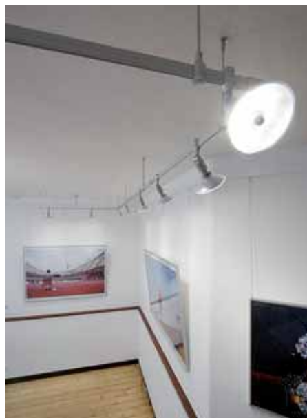
Die 11 Watt Energiesparreflektoren zeichnet eine weiche Lichtverteilung aus
