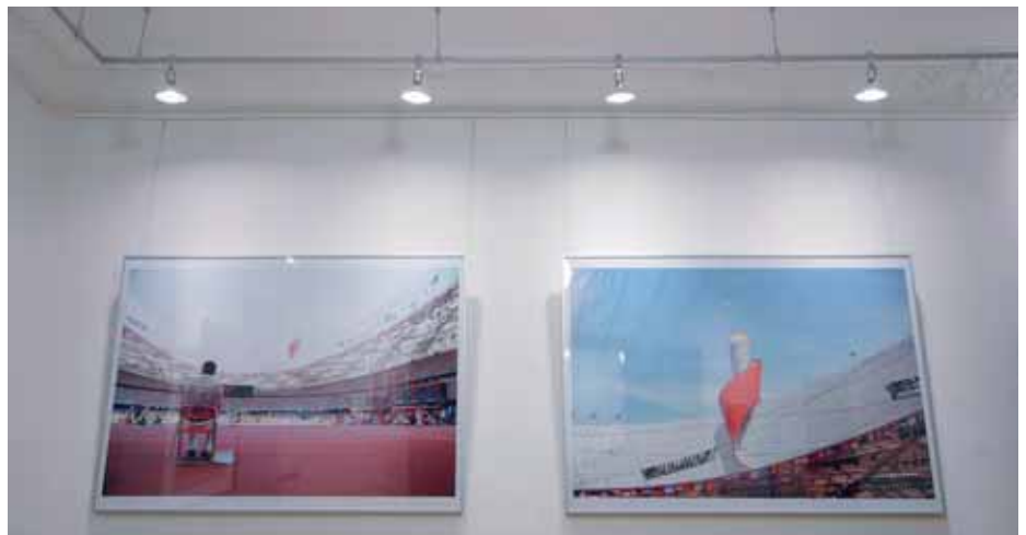
Die 11 Watt Energiesparreflektoren zeichnet eine weiche Lichtverteilung aus
