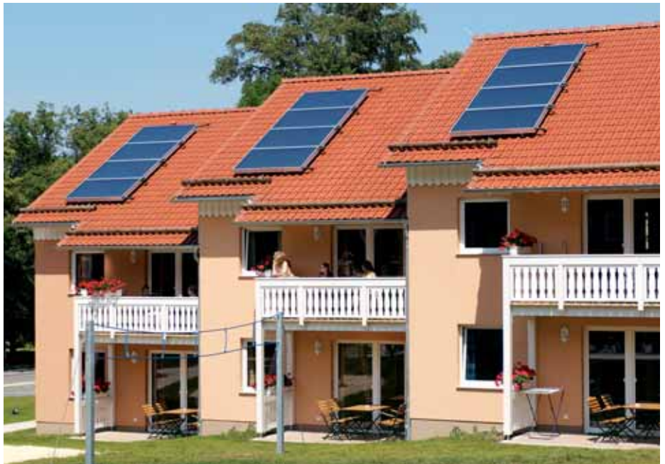
2008 nutzten bereits mehr als drei Millionen Bundesbürger kostenfreie Solarenergie. Angesichts der absehbaren Kostensteigerungen für fossile Energieträger und hoher staatlicher Zuschüsse rentieren sich Solarkollektoren immer schneller. Foto: Vaillant
